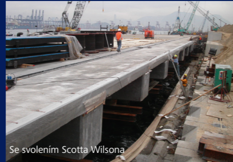
Kontejnerový Terminál č. 9, Hongkong
