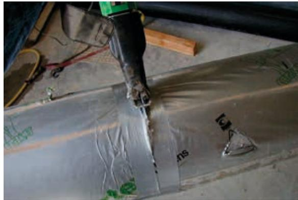
Figure 8.2: Découpe du rouleau Fibertex avec une scie sabre pour plus d'efficacité
