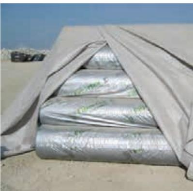
Figure 8.3: Stockage correct sur chantier
