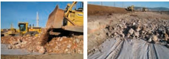
Figure 6.2: Exemples de mise en œuvre demandant une absorption d'énergie élevée par le géotextile
