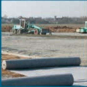
Straßen- u. Eisenbahnbau
