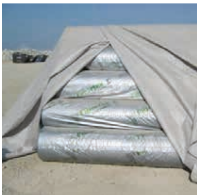
Abbildung 8.3 Ordnungsgemäße Lagerung vor Ort
