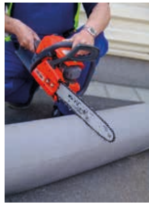
Abbildung 8.2 Schneiden der Fibertex-Rolle mit einer Kettensäge
