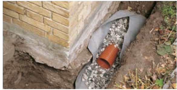
Abbildung 6.7 Beispiel einer Verlegung in Entwässerungsgräben
