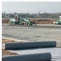
Straßen- und Eisenbahnbau
