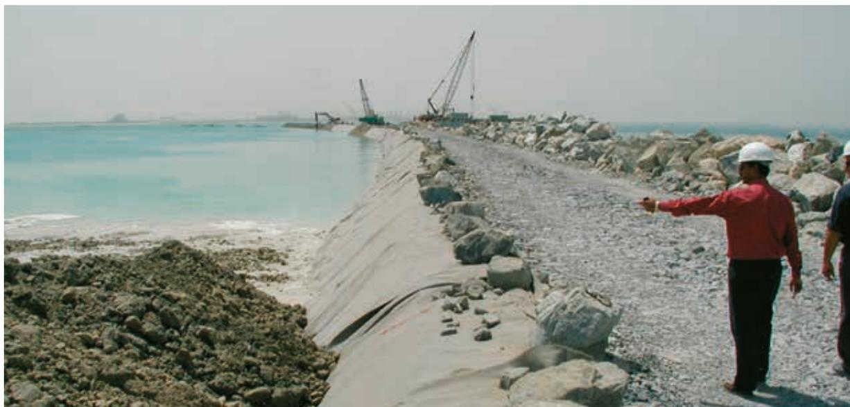
Palm Island, Dubai. Instalação de Fibertex F-650M. O Geotextil Fibertex será coberto com gravilha e areia.
