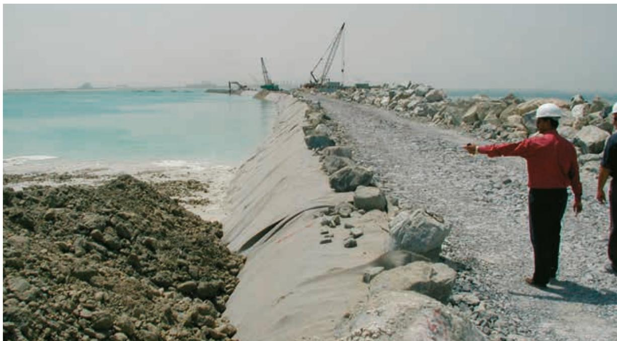
Photo: Palm Island DUBAI. Installation de Fibertex F650M. Ce geotextile de filtration sera complètement recouvert de sable et blocs rocheux.
