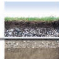
Los geotextiles Fibertex estabilizan el césped, y al separar los terrenos de la capa drenante, facilitan un drenaje rápido y una superficie plana y estable.
