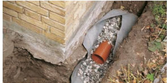
Abbildung 6.7 Beispiel einer Verlegung in Entwässerungsgräben
