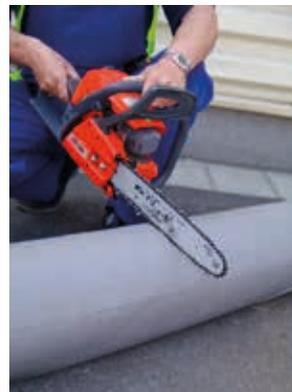
Abbildung 8.2 Schneiden der Fibertex-Rolle mit einer Kettensäge
