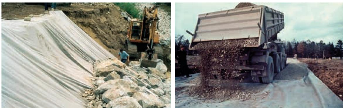
Abbildung 6.2 Beispiele für Anwendungen, die eine hohe Energieabsorption durch das Geotextil erfordern
