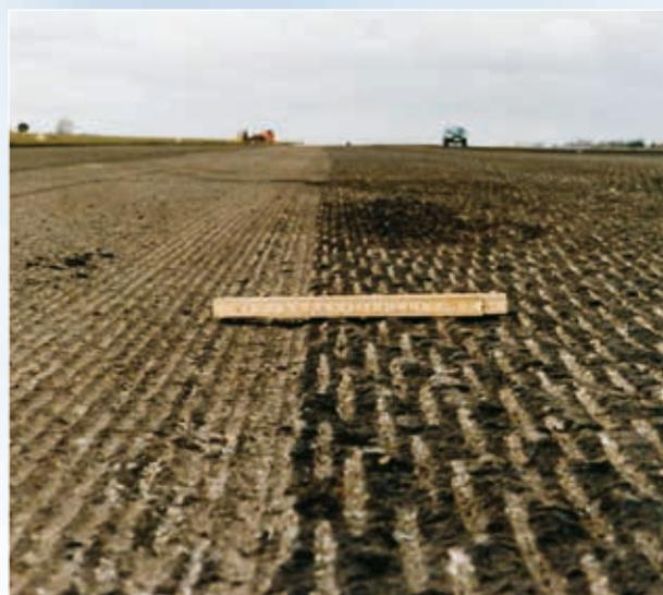
Um eine optimale Basis für die neue Deckschicht zu erhalten, entschied sich die Bauleitung, die obere Schicht des alten Asphaltbelags abzufräsen. Dadurch entstanden tiefe Fräsrillen in der Oberfläche.
