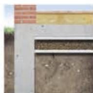
Уложенные под почвенный настилом водопроницаемые геотекстили Fibertex защищают дренажный слой от загрязнения со стороны бетона и основания.
