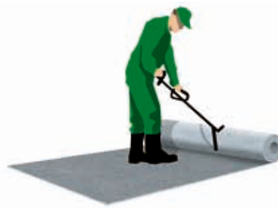
Рис 5. При раскатывании Fibertex AM-2 вручную рекомендуется использовать толкатель, который позволяет легче удерживать направление и избегать складок.
