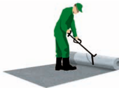
Fig. 5 Desenrollado de Fibertex AM-2 mediante un utillaje especial. Facilita el mantenimiento de una dirección constante y evita la formación de arrugas.
