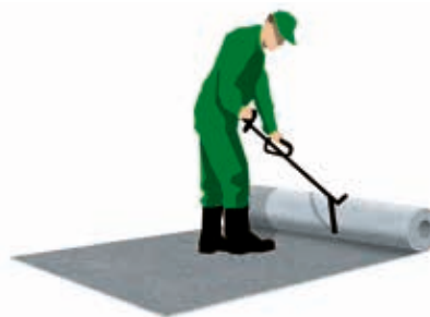
Fig. 5. Ved manuel udrulning af Fibertex AM-2 gør brugen af et skubbejern det nemmere at bibeholde retningen og undgå folder.
