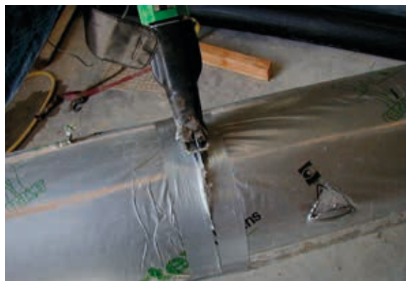
Figure 8.2: Découpe du rouleau Fibertex avec une scie sabre pour plus d'efficacité
