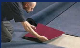
Revêtement de sol
