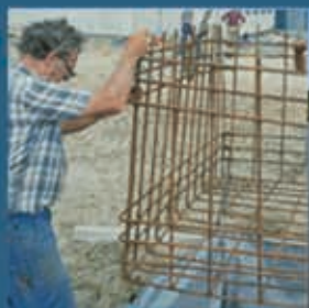
Travaux de construction
