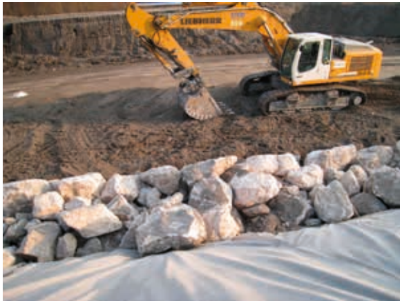
Figure 6.10: Exemple de travaux hydrauliques de protection côtière
