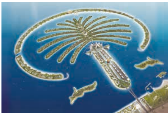
Figure 1.2: Géotextiles Fibertex utilisés aux Iles Palmiers/Dubai
