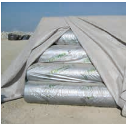
Figure 8.3: Stockage correct sur chantier
