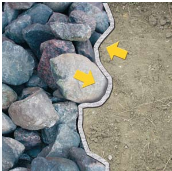
Fig. 8. Stor forlængelse tillader geotekstilet at tilpasse sig til den ujævne konstruktionsoverflade.
