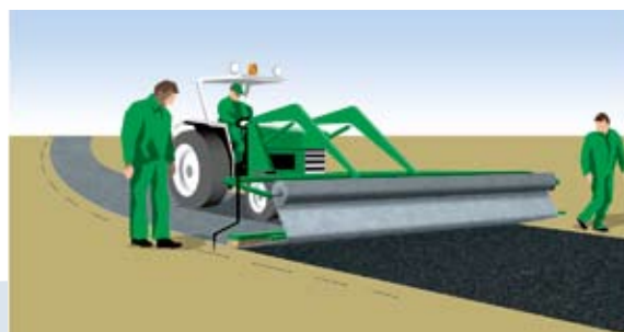
Fig. 6. Le déroulage mécanique de la nappe Fibertex AM2 Spécial est rapide et réduit les plis, même dans des courbes légères.
