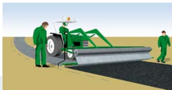
Fig. 6. Maskinel udrulning af Fibertex AM2 Speciel er hurtig og reducerer folder selv ved bløde kurver.
