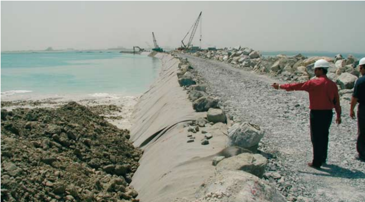
Palm Island, Dubai. Installation von Fibertex F-650M. Das Fibertex Geotextil wird komplett mit groben Gestein, Kies und Sand abgedeckt.
