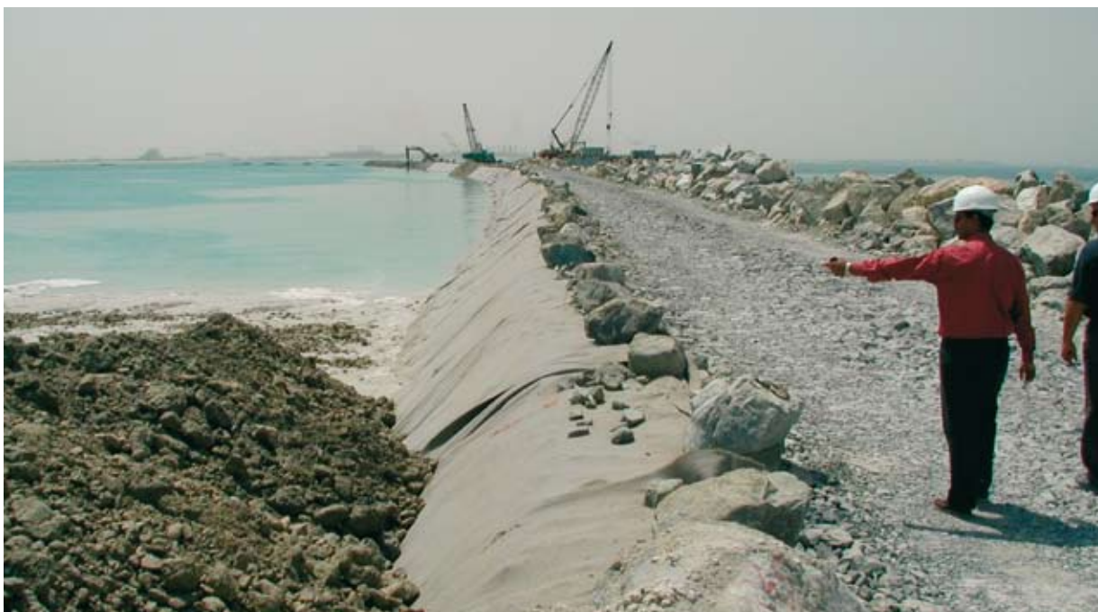
Kilde: Palm Island, Dubai. Installation af Fibertex F-650M. Fibertex Geotextilet vil blive dækket helt af grus og sand.
