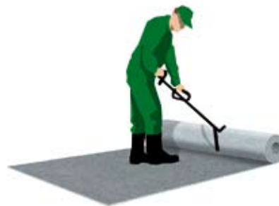
Fig. 5. Para desenrolar Fibertex AM2 manualmente é aconselhável a utilização de um suporte de ferro para facilitar a direcção do rolo, evitando assim as dobras na tela.
