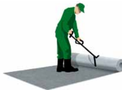
Obr. 5. Při ruční pokládce textilie Fibertex AM2 je vhodné používat postrkovací vidlici, kterou se lépe drží směr a předchází se vrásnění.
