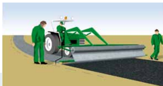
Obr. 6. Mechanická pokládka textilie Fibertex AM2 Special je rychlá a minimalizuje vrásnění i v jemných zatáčkách.
